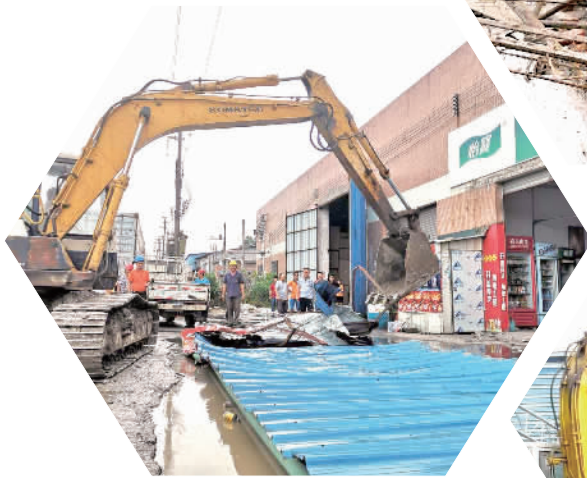
工作人员冒雨拆除违规搭建的铁棚。
