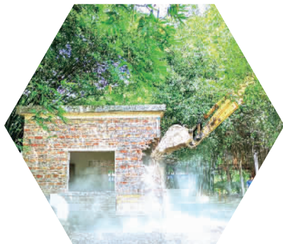
依法拆除平沙岛的违法建筑。
