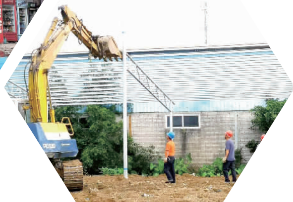
西樵镇查治办对海舟村一宗违法停车场依法进行拆除。
