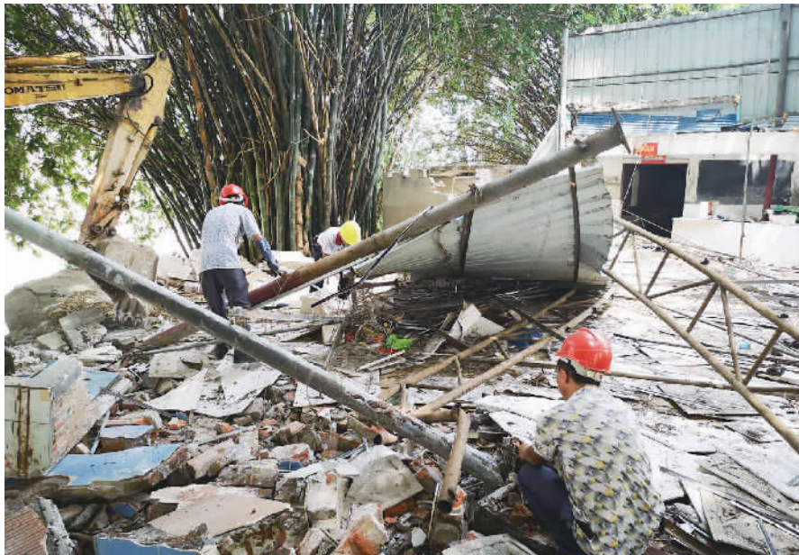
清拆工人正在清理挖掘机拆除的铁棚。
