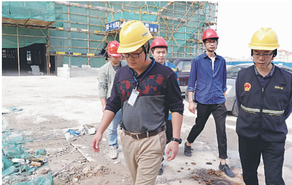
西樵镇副镇长陈俊勋带队检查建筑工地。
