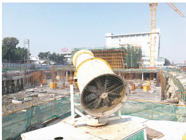
西樵农民公寓工地防尘雾炮机。
