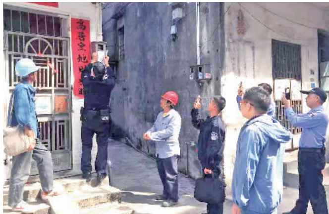
行动组工作人员对拒不整改出租屋采取停电措施。
