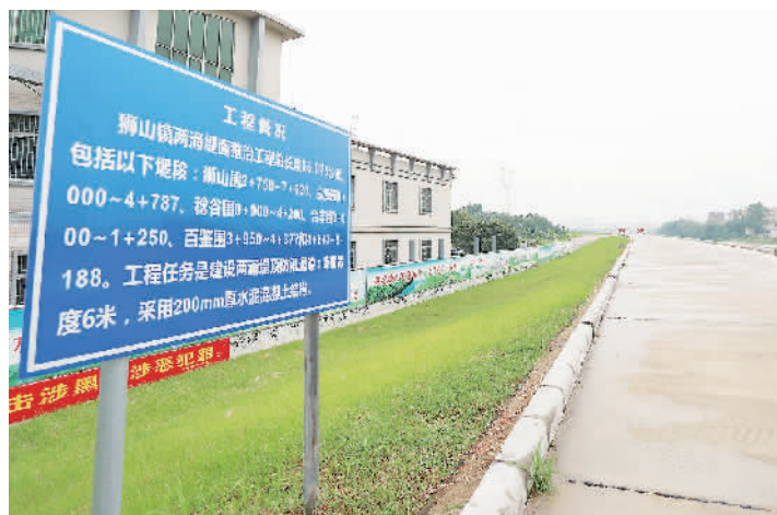
狮山镇两涌堤面整治工程实施后，堤面变成了水泥路。
