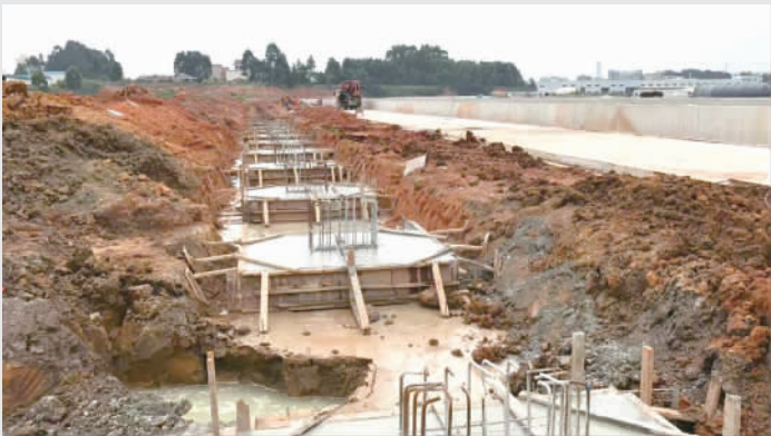
工地建设现场。
