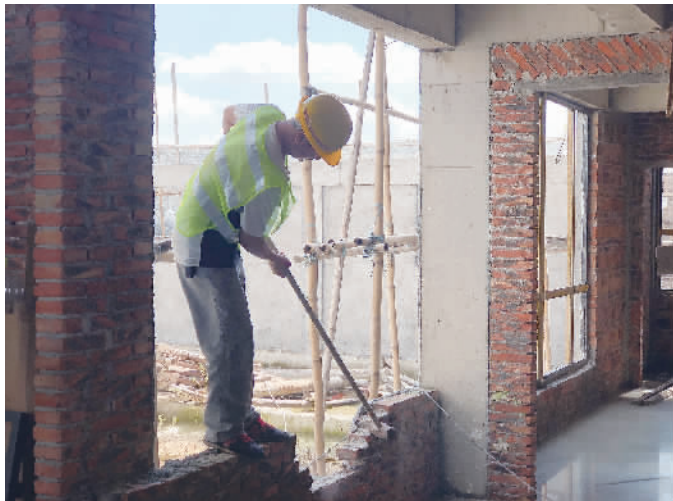
工作人员正在拆除违规楼层墙面。
