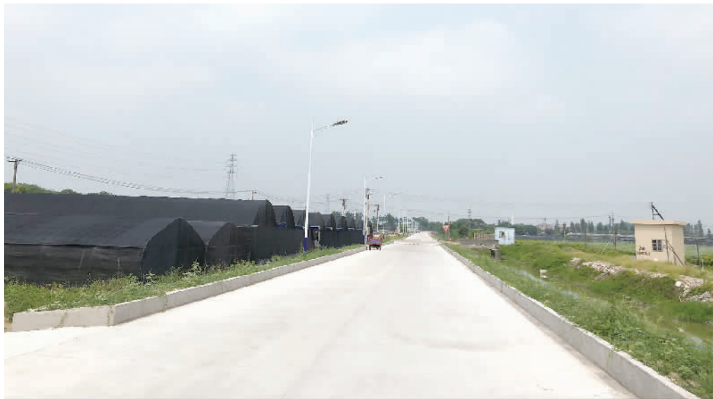
大官路全线贯通。
