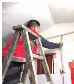
为孤寡长者检修电线现场。
