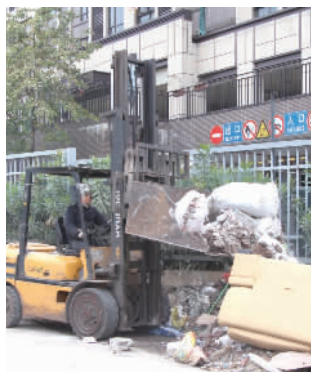
利用铲车清理大型垃圾堆放物。
