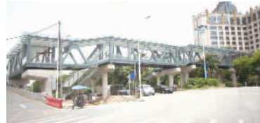
杏花隧道口人行天桥将于月底投入使用。
