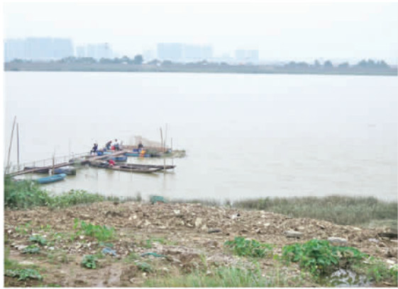
海寿村诗歌园餐厅对出马路旁积存渣土。
