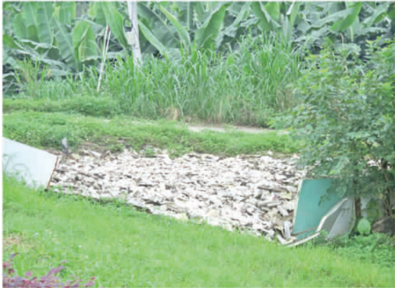
海寿村C13280号灯柱旁积存垃圾。
