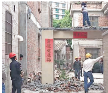
违建拆除现场。
