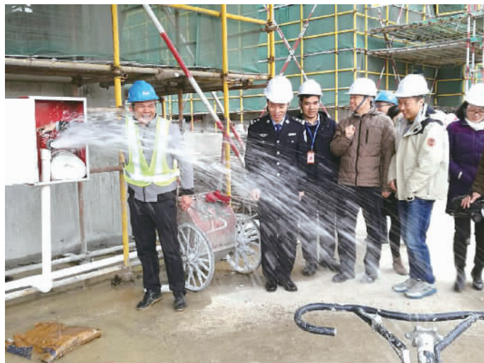
督导组查看消防设施情况。
