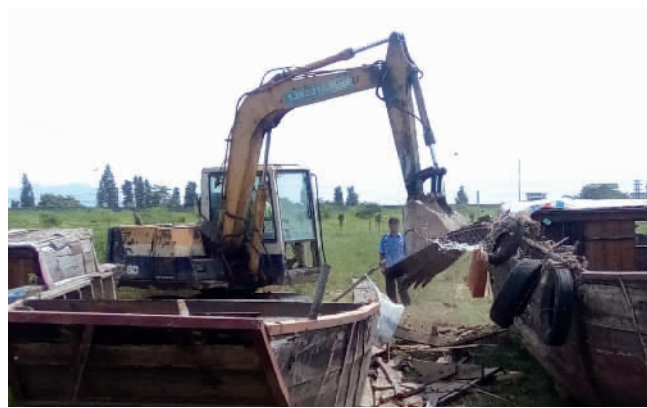
非法捕捞工具被拆除。
