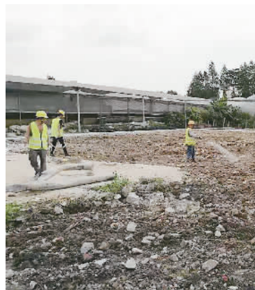
施工人员对硬地拆除后进行复绿工作。
