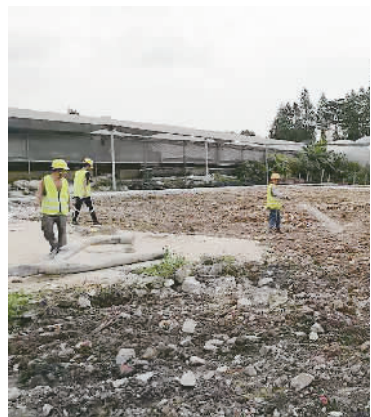
施工人员对硬地拆除后进行复绿工作。
