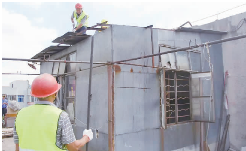
施工人员在拆除违规搭建的雨棚。
