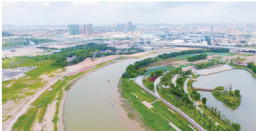
槽尾撬水道堤防整治工程。
