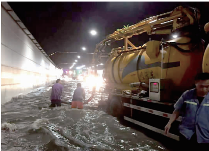
市政工作人员使用吸污车对排水管道内的淤积物进行抽吸。通讯员供图
