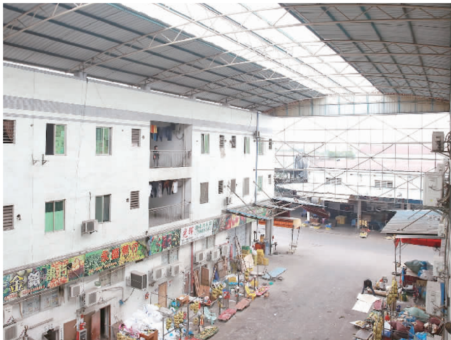
在夏西水果批发市场,消防通道上方违规搭建的星瓦棚中间已被拆除六米,留出“出烟口”。
