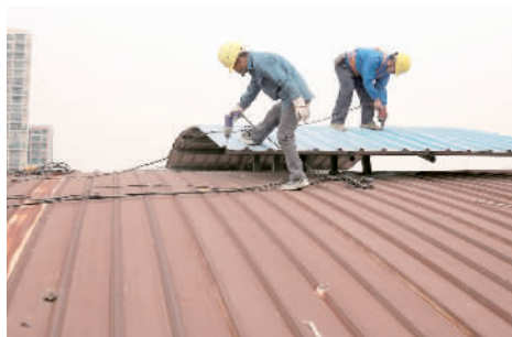
施工人员正在拆卸违规搭建的星瓦棚。
