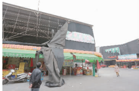
施工人员正在拆除黑色的遮阳布。
