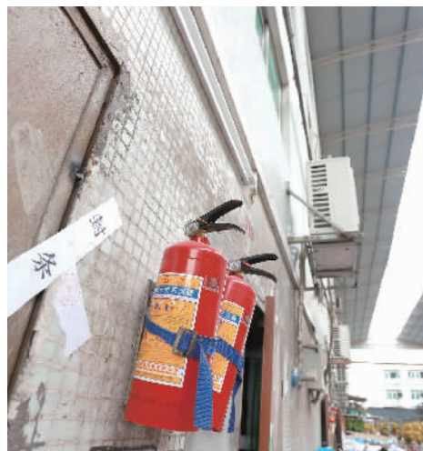
为防止“回巢”,档铺夹层入口被焊死并贴上封条。
