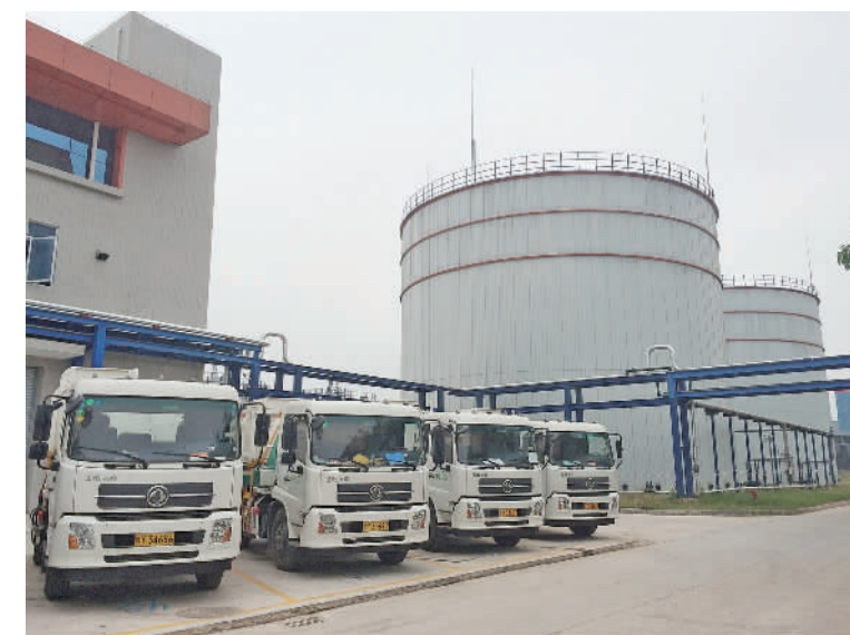
■南海区餐厨垃圾处理厂。
