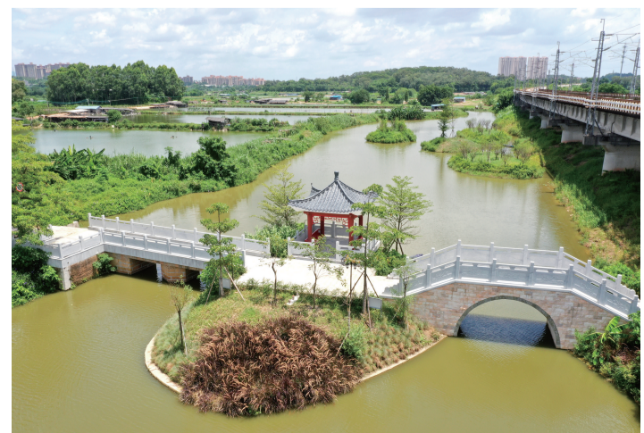
■“有为水道”西城段风光。
