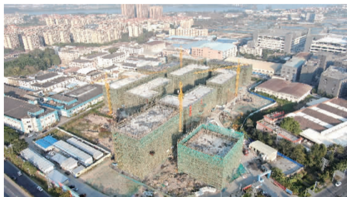
■2020年底,五八科创园一期主体建筑封顶。
