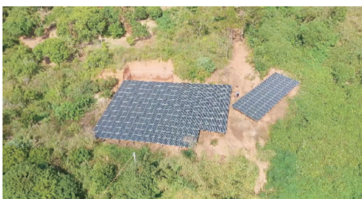
■云浮市罗定市黎少镇大塘村光伏发电项目。
