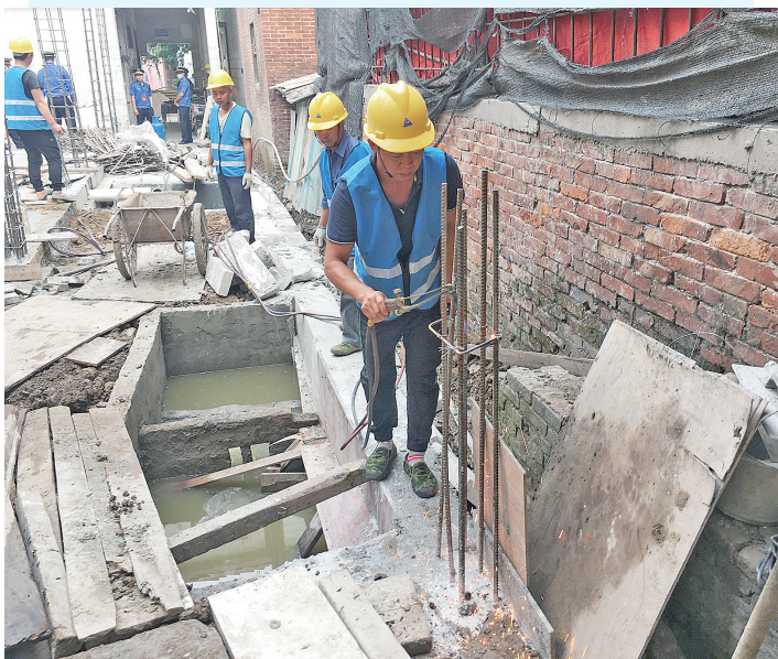
▼施工人员对叠北社区上报的超红线范围的宅基地进行割钢筋处理。通讯员供图
