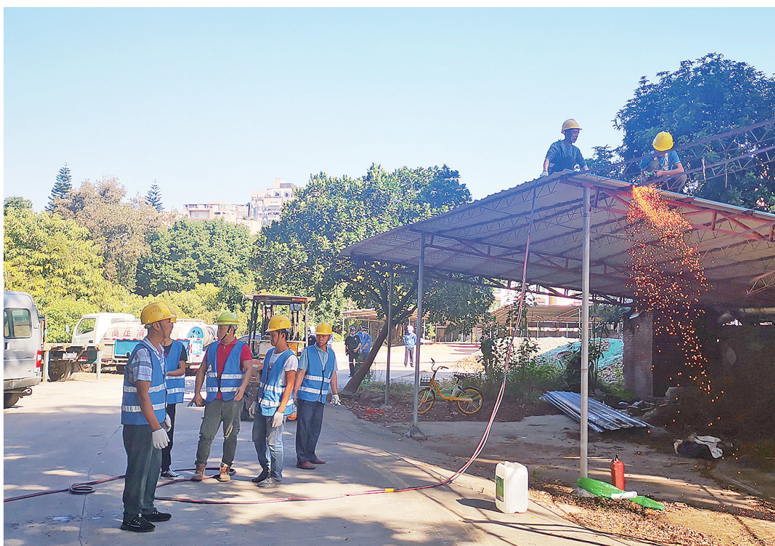
▲11月13日，施工人员拆除叠北社区违建铁棚。 珠江时报记者 丁当 摄
