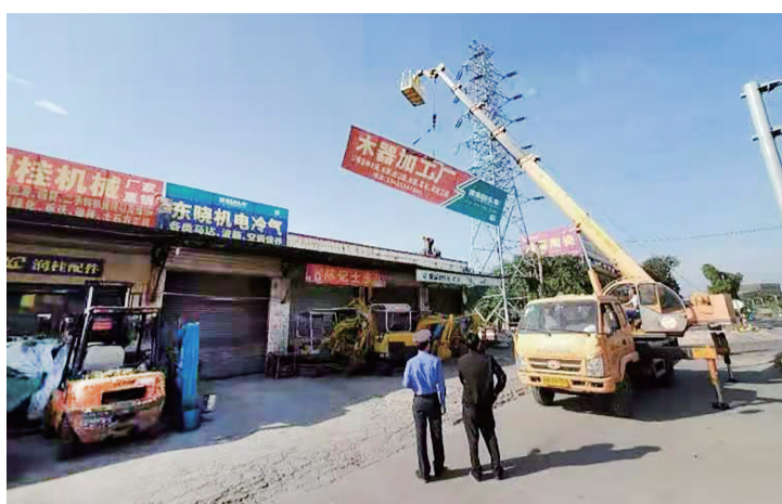
执法人员拆除违规广告牌。(通讯员供图)
