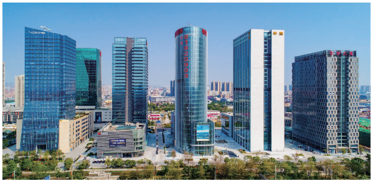
■大沥有色金属企业总部楼群。
