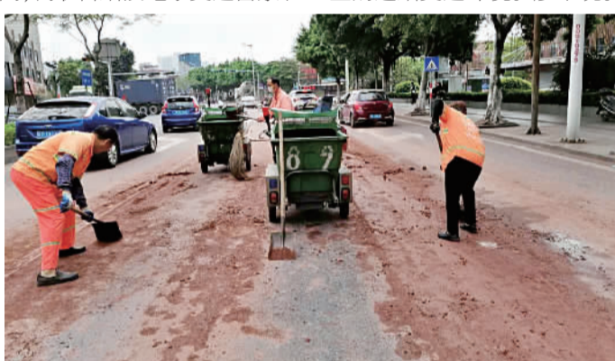
环卫工人清理路面渣土。(通讯员供图)
