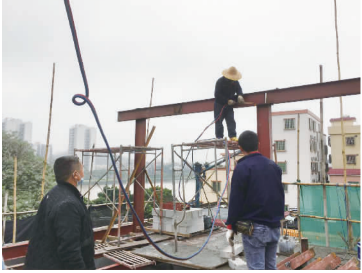
■平东社区违建事主自拆第五层钢结构违法搭建物。(通讯员供图)
