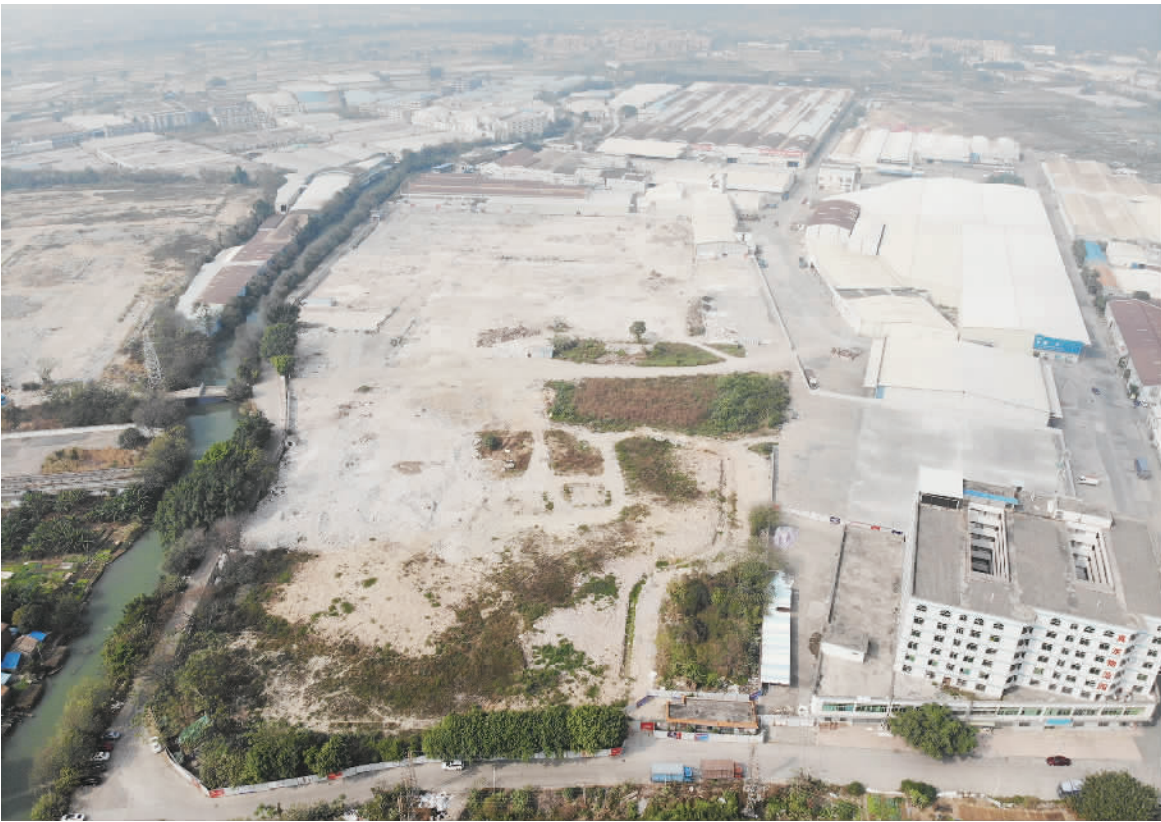
■中兴新城520亩厂房拆除完成后的航拍图。
