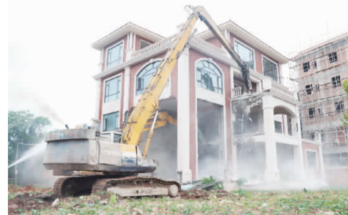
■清拆人员驾驶大型机械,拆除违建。
