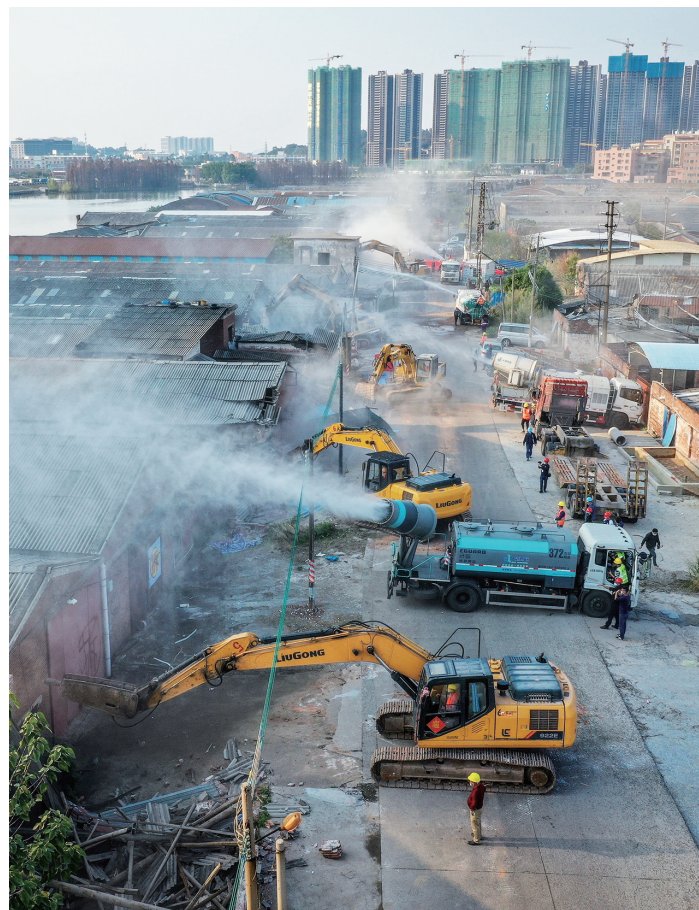
■大沥镇大沙工业区清拆现场。2月21日,南海7镇街村级工业园升级改造项目全面复工。
