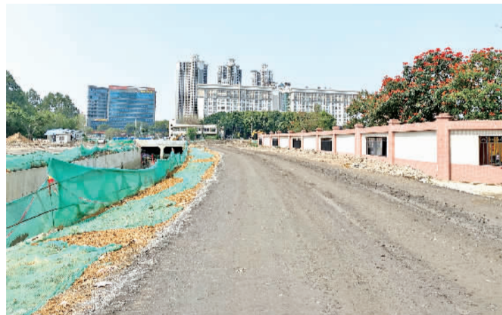
西樵镇新城区路网建设工程(一期)有望在10月1日前通车。
