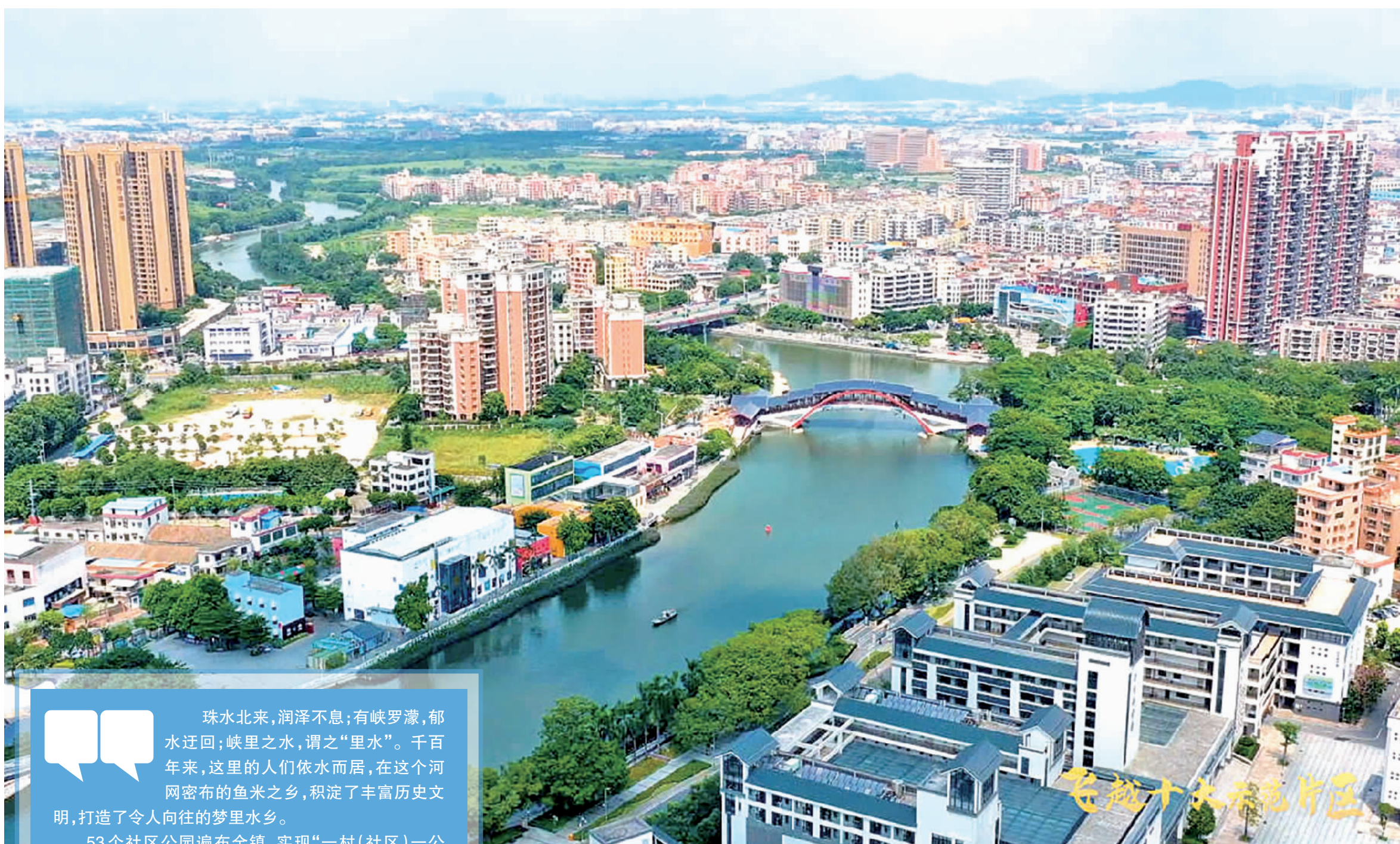
■里水一河三岸美丽景色,展现了里水乡村振兴的成效。 珠江时报记者/方智恒 摄
