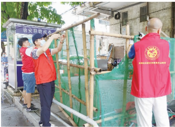
■桂二社区党员志愿者拆除防疫岗护栏。
