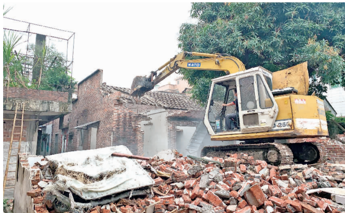
■施工队伍拆除林岳社区西二村违建。
