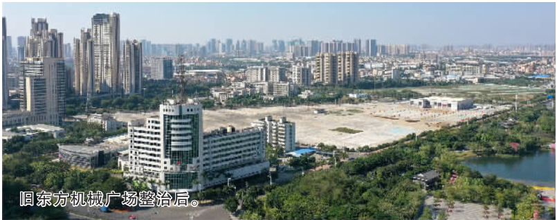
旧东方机械厂整治前。
